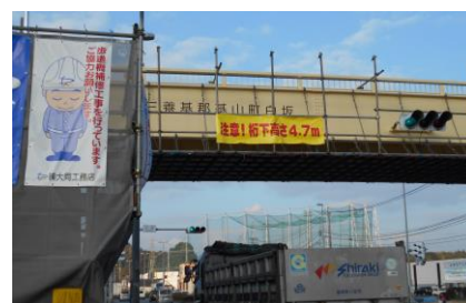
もうすぐ工事が終わります
